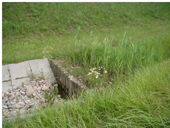
Ryc. 4.119. Przykład palisady wzmocnionej narzutem z otoczków i faszyną
