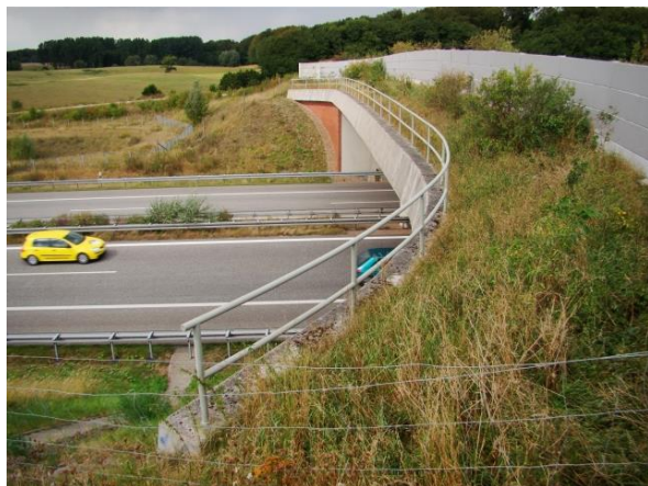
Ryc. 6.55. Zagospodarowanie wałów ziemnych na półce za ekranem betonowym (strona zachodnia)
