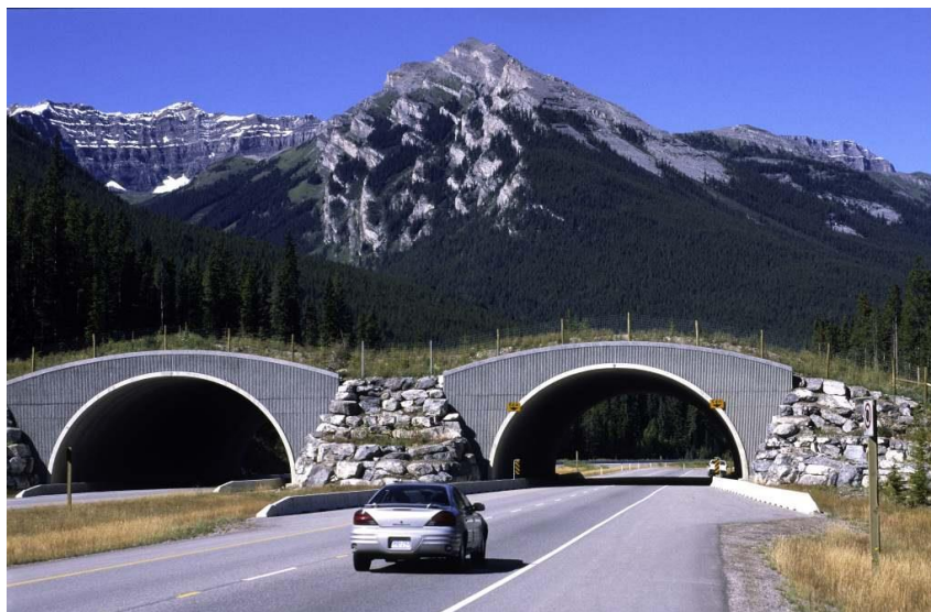
Ryc. 1.9. Przykład dobrej asymilacji przejścia z otoczeniem – przejście górne wybudowane w Kanadzie nad autostradą A1 w Parku Narodowym Banff Źródło: fot. Marcel Huijser [94].
