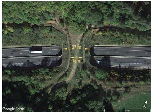
Ryc. 4.49. Przejście zespolone z ukośnie zlokalizowaną drogą gruntową przecinającą w poprzek otwartą strefę migracji, o szerokości 18 m (szerokość obiektu wynosi 37 m) Źródło: zdjęcie satelitarne z Google Earth [163].
