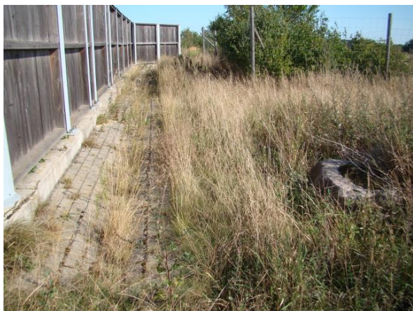
Ryc. 4.92. Ściek z kostki betonowej odprowadzający wodę opadającą ze strefy migracji
