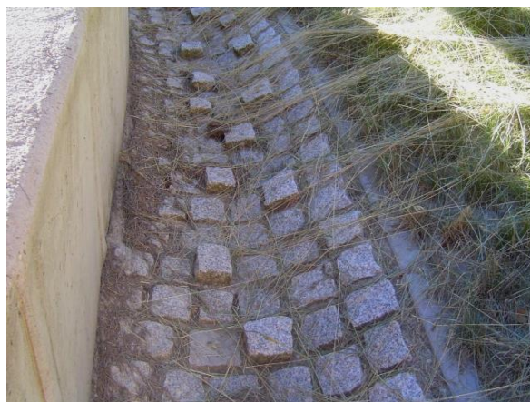
Ryc. 4.98. Ściek z kostki kamiennej (typu mulda) przy łukowej krawędzi obiektu
