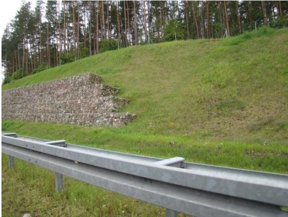
Ryc. 4.114. Przykładowe wzmocnienie skarp gabionami
