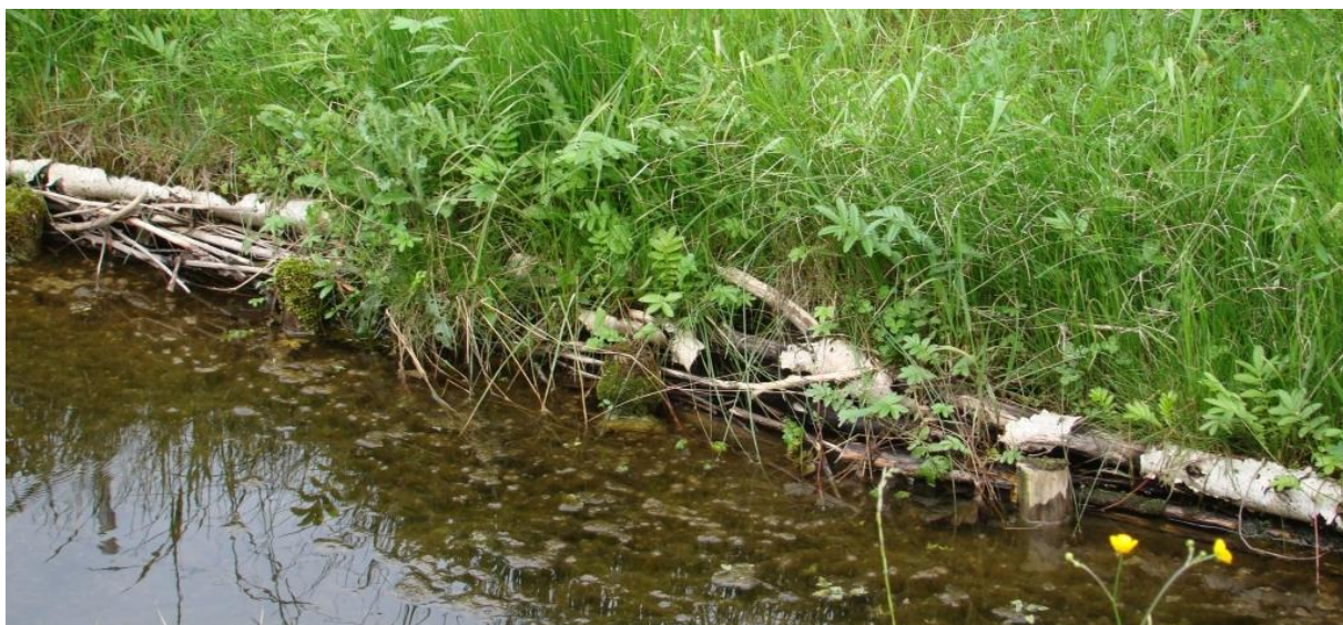
Ryc. 4.117. Przykładowe zabezpieczenie brzegu cieków faszyną
