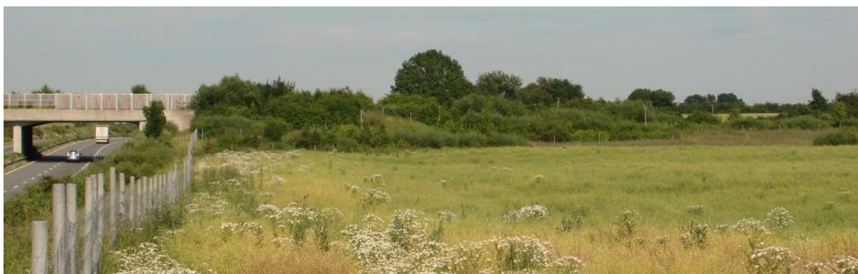
Ryc. 4.12. Przykład przejścia górnego, na którym w strefie dojścia i najścia zastosowano odpowiednie nasadzenia, co stworzyło wrażenie przedłużenia siedliska i przyczyniło się do lepszej funkcjonalności tego przejścia
