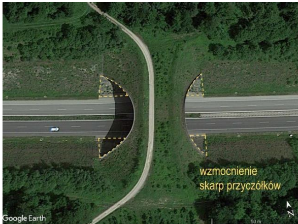
Ryc. 4.110. Przejście górne Kalkofen nad drogą 98 w Niemczech, koło Kalkofen Źródło: zdjęcie satelitarne z Google Earth [163].
