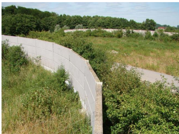
Ryc. 6.12. Widok na powierzchnię górnego przejścia i ekrany betonowe
