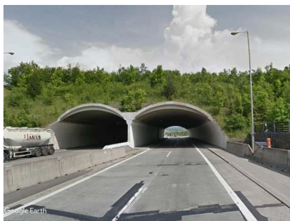
Ryc. 3.11b. Wystające czola blach falistych, bez naziomu, na moście zielonym w Czechach Źródło: fot. Street View [164].
