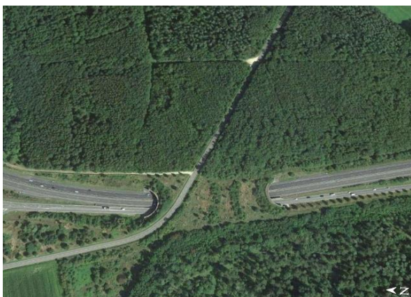
Ryc. 2.19. Przykład połączenia warunków biotycznych i abiotycznych na przejściu górnym zespolonym (Luxemburg nad autostradą A1, w pobliżu wsi Pettingen) Źródło: zdjęcie satelitarne z Google Earth [163].
