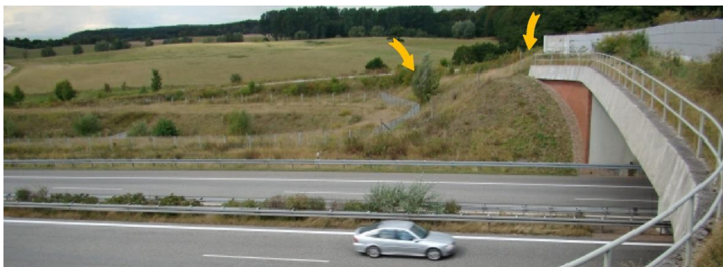
Ryc. 6.19. Lokalizacja punktu G1 (w strefie dojścia do obiektu) i punktu G2 (za bardzo krótkim wałem ziemnym uformowanym na przedłużeniu ekranu)
