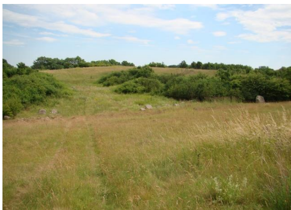
Ryc. 4.74. Duże głazy, o średnicy ok. 1 m, ułożone w szereg na moście zielonym Barnekow w Niemczech
