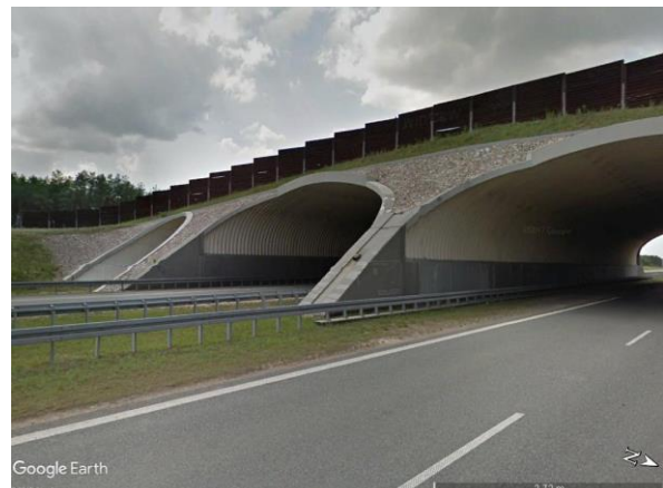
Ryc. 3.4. Różnica dwukrotna długości konstrukcji w odniesieniu do faktycznej szerokości przejścia (przejście w Polsce nad autostradą A2)
