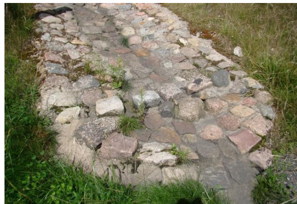
Ryc. 4.106. Ściek typu mulda wykonany z brukowca nieobrobionego i płytowanego, z wypełnieniem spoin zaprawą cementową, z wystającymi pojedynczo kostkami
