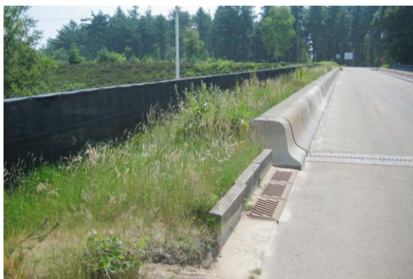
Ryc. 2.11. Przykład strefy migracji małych zwierząt i systemu odwodnienia na przejściu zespolonym w Holandii Źródło: fot. Marcel Huijser [94].
