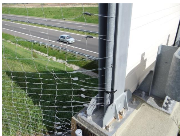
Ryc. 3.88. Wolne od nasadzeń skarpy przyczółku nietworzące żadnej osłony i izolacji
