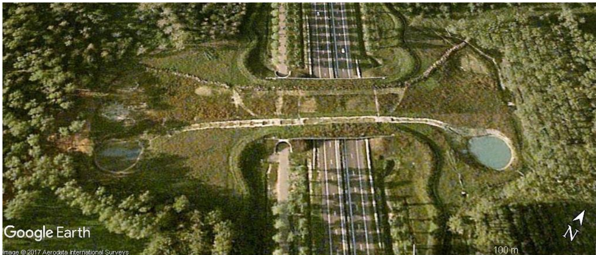
Ryc. 4.6. Zagospodarowanie naprowadzeń i skarp przyczółków na przejściu Ecoduct De Scheeken Źródło: zdjęcie satelitarne z Google Earth [163].
