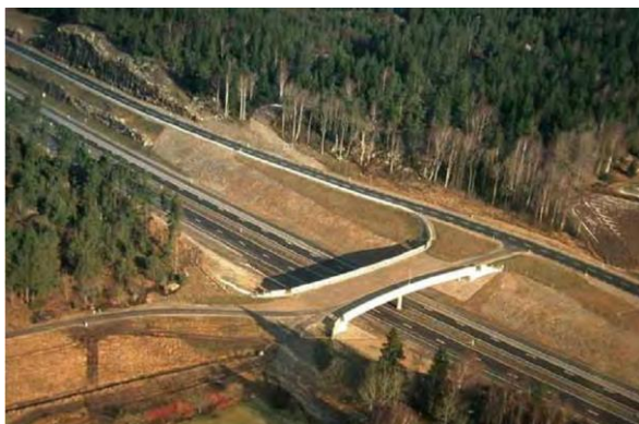
Ryc. 2.57. Pierwszy wiadukt drogowy w Szwecji dostosowany do potrzeb łosia Źródło: fot. Mattias Olsson [39, rys. 7.2, s. 108].
