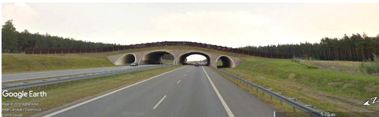
Ryc. 3.5. Widok z drogi polskiego przejścia, na którym wykorzystano całą długość konstrukcji, uzyskując dużą faktyczną szerokość przejścia w strefie migracji Źródło: fot. Street View [164].
