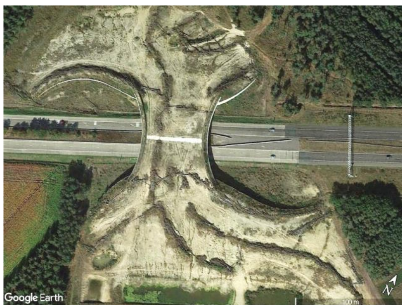
Ryc. 4.3. Zagospodarowanie terenu wokół mostu i strefy migracji na przejściu górnym Kampengrens, wybudowanym w Holandii nad autostradą A67 (stan zagospodarowania bezpośrednio po oddaniu do użytku) Źródło: zdjęcie satelitarne z Google Earth [163].
