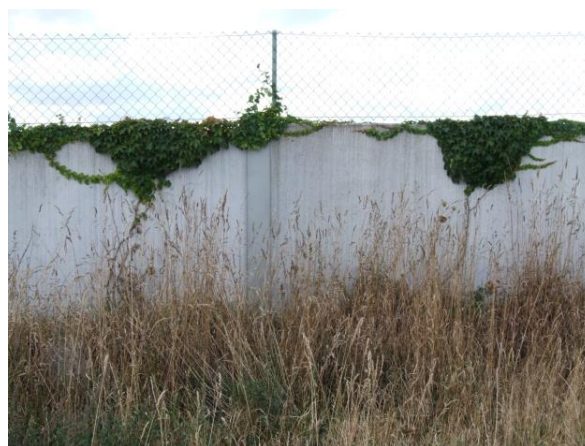
Ryc. 3.81. Ekran betonowy osłonięty wałem i roślinnością z zewnątrz, a bluszczem od strony przejścia Źródło: fot. Mariusz Schab [184].
