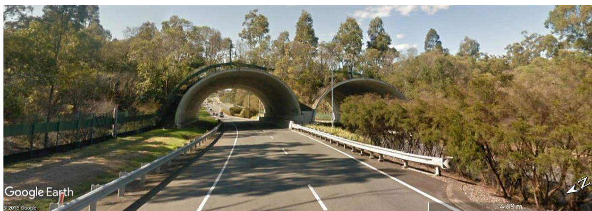
Ryc. 3.10. Widok z drogi australijskiego przejścia, na którym wykorzystano tylko część długości konstrukcji, uzyskując bardzo wąską faktyczną szerokość przejścia w strefie migracji Źródło: fot. Street View [164].
