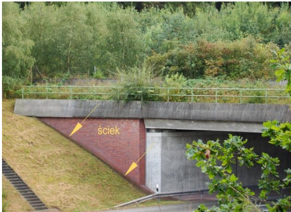
Ryc. 4.104. System odwodnienia odprowadzający wodę z powierzchni konstrukcji do ścieku stycznego do ścian przyczółku (ściek typu mulda wykonany z kostki betonowej)
