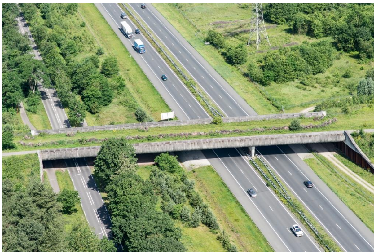
Ryc. 4.83. Odgródenie ścieżki rowerowej Slabroek od strefy migracji wałem uformowanym z karpin Źródło: fot. State of The Netherlands, Ministry of Infrastructure and Environment, Directorate-General Rijkswaterstaat [63].
