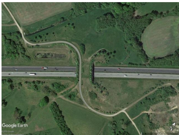
Ryc. 6.38. Przejście górne nad autostradą, z ekranem betonowym; stan zieleni w miesiącach letnich Źródło: zdjęcie satelitarne z Google Earth [163].
