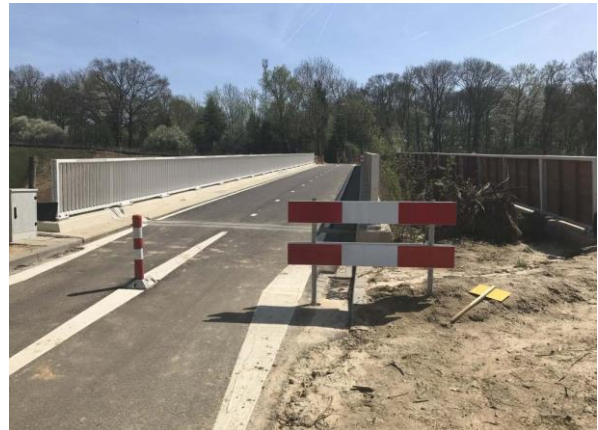
Ryc. 2.10. Zabezpieczenie przejścia zespolonego Vaesrade podczas budowy Źródło: fot. Raymond Tilmans Provincie Limburg, Holandia [221].
