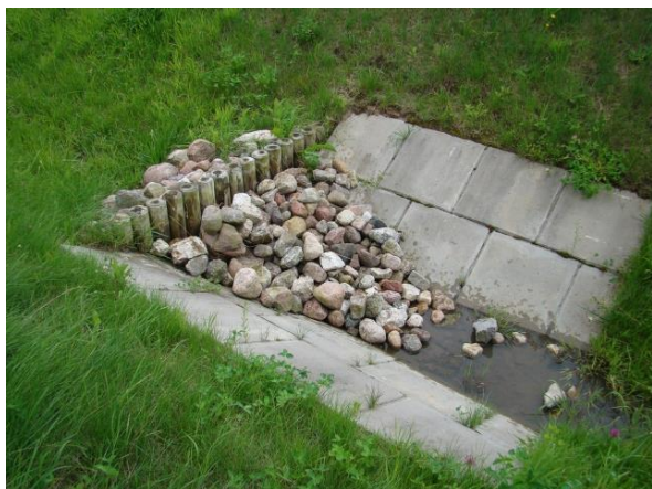
Ryc. 4.118. Przykład palisady wzmocnionej obustronnie narzutem z otoczków
