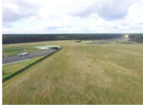
Ryc. 3.39. Powierzchnia przejścia wynosząca 8 ha – stan cztery lata po oddaniu drogi do eksploatacji Źródło: fot. Piotr Pacelik [156].
