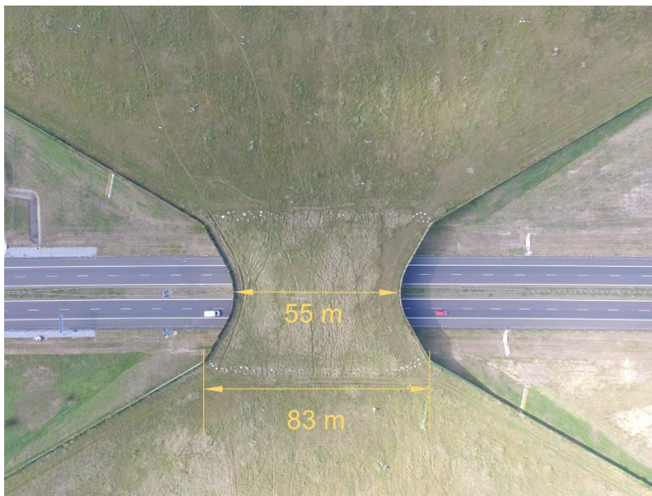
Ryc. 3.36. Widok z góry fragmentu przejścia PZD-25, o szerokości najścia w linii przyczołku 83 m, faktycznej szerokości przejścia 55 m Źródło: fot. Piotr Pacelik [156].
