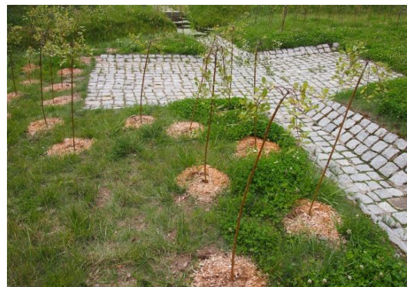
Ryc. 4.121. Niedopuszczalne na terenie przejścia miejsca wybrukowane (posadzone młode, słabo rozwinięte, krzewy nie zasłaniają zastosowanego elementu odwodnienia) Źródło: fot. Radosław Maron [134].
