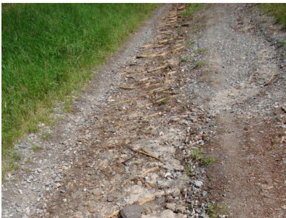
Ryc. 4.116. Ażurowa taśma siatkowa stabilizująca podłoże i spowalniająca sływ wody na obiekt
