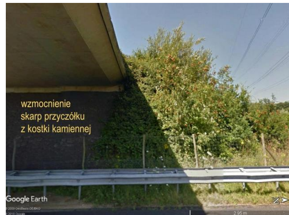
Ryc. 4.113. Przykład wzmocnienia skarpy pod obiektem i zastosowania tradycyjnego systemu odwodnienia, przy wąskich przejściach w regionach z krótką zimą lub z bezśnieżnym okresem zimowym Źródło: fot. Street View [164].
