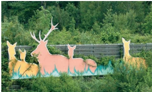
Ryc. 4.89. Przykład oznakowania przejścia ekologicznego kolorowymi podobiznami zwierząt na tle zieleni Źródło: fot. APRR / Alain Joveniaux-EPA [123].
