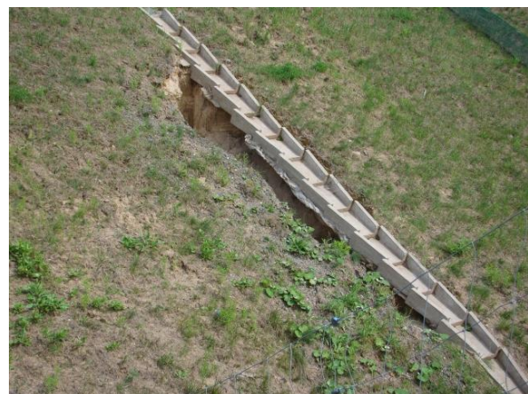
Ryc. 4.108. Ściek skarpowy wykonany z betonowych elementów prefabrykowanych
