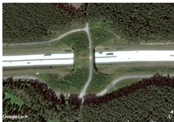
Ryc. 3.70. Stan zagospodarowania mostu zielonego po dziewięciu latach od oddania go do użytku Źródło: zdjęcie satelitarne z Google Earth [163].
