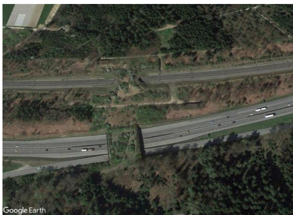
Ryc. 2.17. Przykład zachowania ciągłości tras migracji na podwójnym przejściu wybudowanym w Szwajcarii nad linią kolejową, autostradą A1 i drogą krajową nr 1 Źródło: zdjęcie satelitarne z Google Earth [163]
