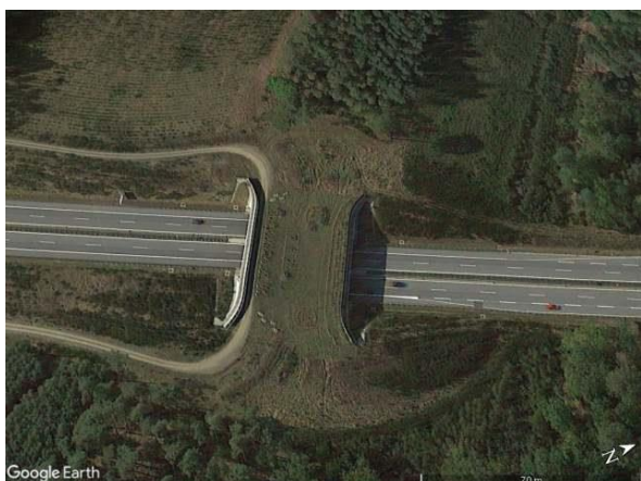
Ryc. 4.72. Stan początkowego zagospodarowania w 2009 r. strefy migracji i najść na przejście zespolone Źródło: zdjęcie satelitarne z Google Earth [163].
