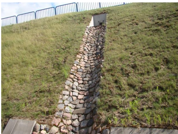
Ryc. 4.107. Przykładowy ściek skarpowy typu mulda wykonany z brukowca nieobrobionego
