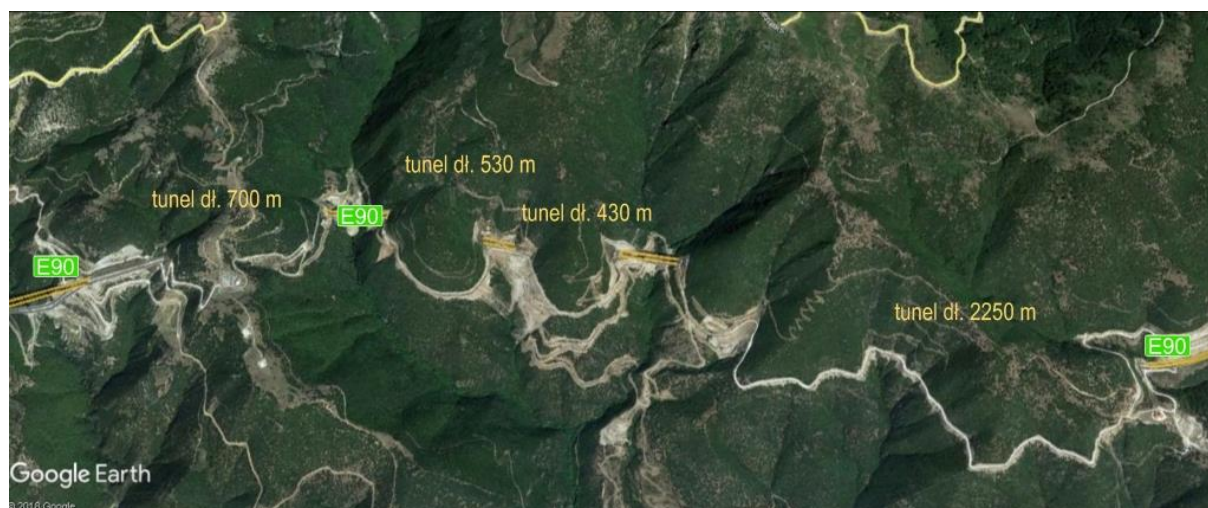
Ryc. 3.56. Zdjęcie satelitarne fragmentu autostrady Egnatia E90, prowadzącej przez pasmo górskie, i cztery tunele stanowiące równocześnie przejścia górne Źródło: zdjęcie satelitarne z Google Earth [163].
