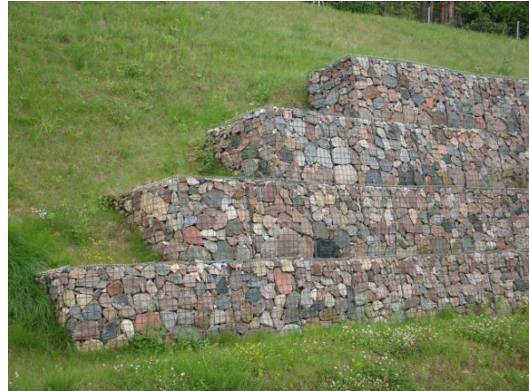
Ryc. 4.115. Przykład stopni wykonanych z gabionów na skarpach w otoczeniu przejścia górnego
