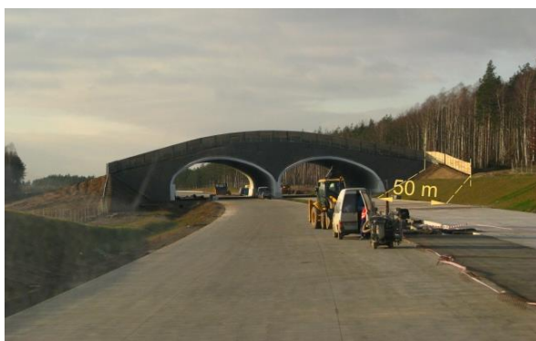
Ryc. 3.65. Przykład ekranu, o długości 50 m, równoległego do drogi, przy braku jakiegokolwiek naprowadzenia (stan budowy)
