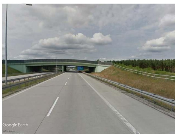
Ryc. 3.47b. Zagospodarowanie skarp wykopu i strefy najścia na moście zielonym w Polsce nad autostradą A4 Źródło: fot. Street View [164].
