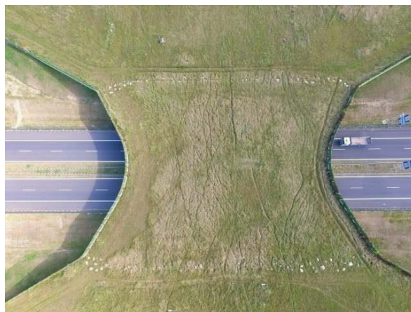
Ryc. 4.75. Głazy ułożone w szereg przy wejściu w strefę migracji na moście zielonym wybudowanym na drogą ekspresową S3 w Polsce, koło Popowa Źródło: fot. Piotr Pacelik [156].
