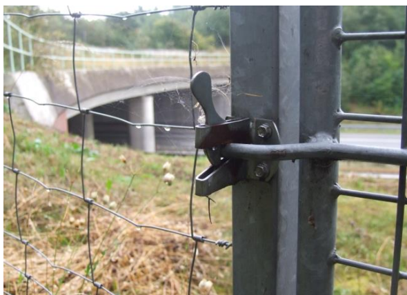
Ryc. 4.20. Przykład furtki zastosowanej w ogrodzeniu z zamkiem sprężynowym Źródło: fot. Mariusz Schab [184].
