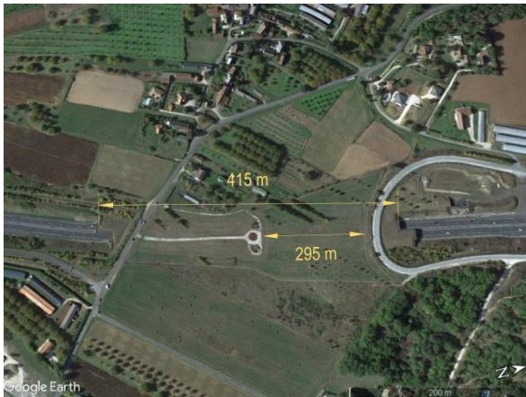
Ryc. 4.38. Przykład przejścia nad autostradą A20 we Francji (szerokość obiektu – 415 m, faktyczna szerokość przejścia – 295 m) Źródło: zdjęcie satelitarne z Google Earth [163].
