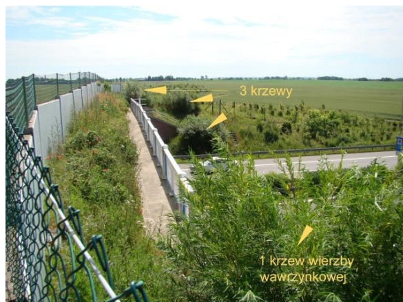
Ryc. 4.10b. Przykład bardzo słabo zagospodarowanej skarpy przy przyczółku, niezapewniającej dobrej osłony przeciwołnieniowej i przeciwhałasowej dla zwierząt
