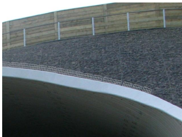
Ryc. 4.124. Widok detali płotków zastosowanych na krawędzi obiektu
