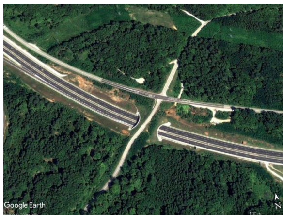
Ryc. 2.28. Przejście z dobrą oceną wielokryterialną, ale wzbudzające wiele wątpliwości co do jego funkcjonalności z powodu bliskiej lokalizacji skrzyżowania skanalizowanego Źródło: zdjęcie satelitarne z Google Earth [163].
