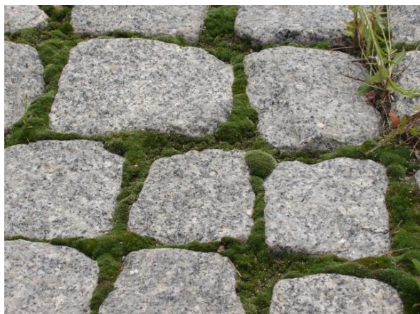
Ryc. 4.109. Spoiny wypełnione gruntem i zarośnięte mchem oraz zaroślami
