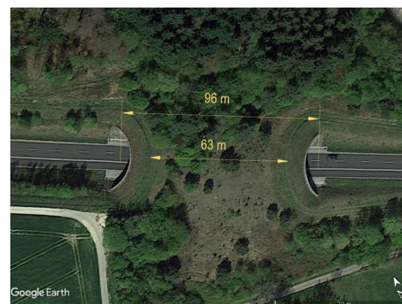
Ryc. 4.62. Most krajobrazowy Weiherholz (szerokość w strefie najścia – 96 m, największa szerokość obiektu – 81 m, faktyczna szerokość w strefie migracji – 63 m) Źródło: zdjęcie satelitarne z Google Earth [163].
