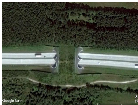
Ryc. 3.68. Stan zagospodarowania strefy najścia i migracji po dziewięciu latach od oddania przejścia do użytku Źródło: zdjęcie satelitarne z Google Earth [163].
