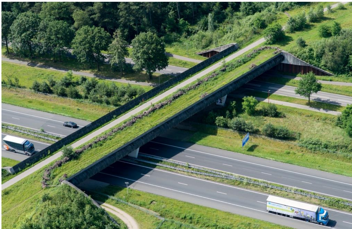
Ryc. 4.80. Zmienione po kilku latach zagospodarowanie powierzchni mostu zielonego Slabroek Źródło: fot. State of The Netherlands, Ministry of Infrastructure and Environment, Directorate-General Rijkswaterstaat [63].
