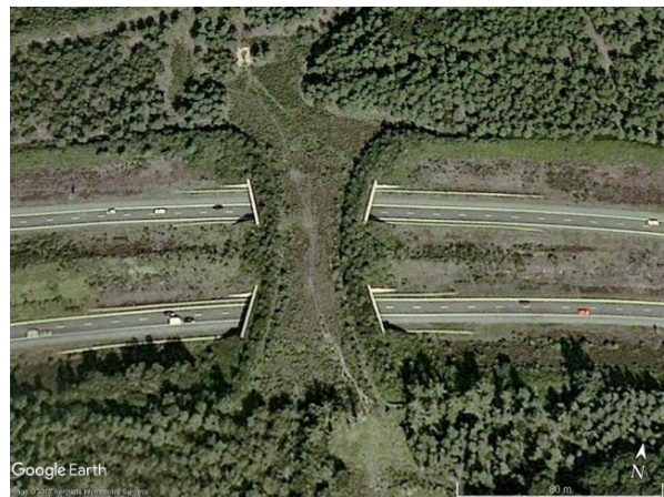
Ryc. 3.29d. Przejście Kootwijk nad A1 w Holandii, o szerokości obiektu 50 m (faktyczna szerokość przejścia wynosi 30 m)
