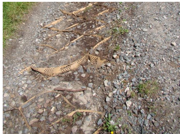
Ryc. 4.116. Ażurowa taśma siatkowa stabilizująca podłoże i spowalniająca sływ wody na obiekt
