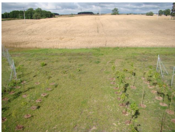
Ryc. 5.32. Przykład nieprawidłowych nasadzeń niezasłaniających ogrodzeń i ograniczających otwartość przejścia; strefa najścia ukształtowana niezgodnie z wytycznymi
