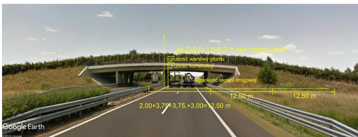
Ryc. 3.28. Różnica wysokości rzędnej jezdni i przejścia dla zwierząt na przejściu górnym na Węgrzech Źródło: jako tło ryciny wykorzystano fot. Street View [164]
