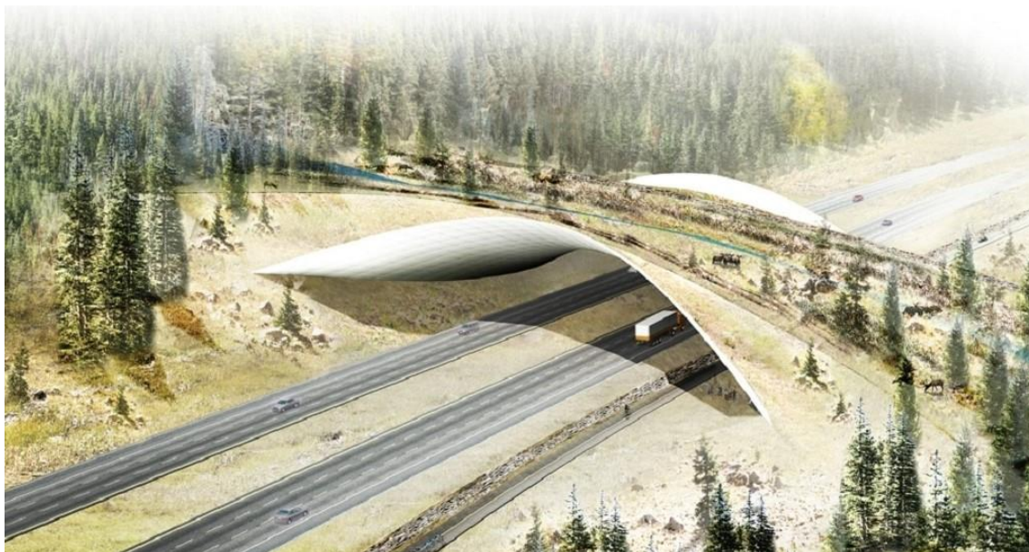
Ryc. 3.92. Optymalny kształt i konstrukcja mostu zielonego najnowszej generacji
