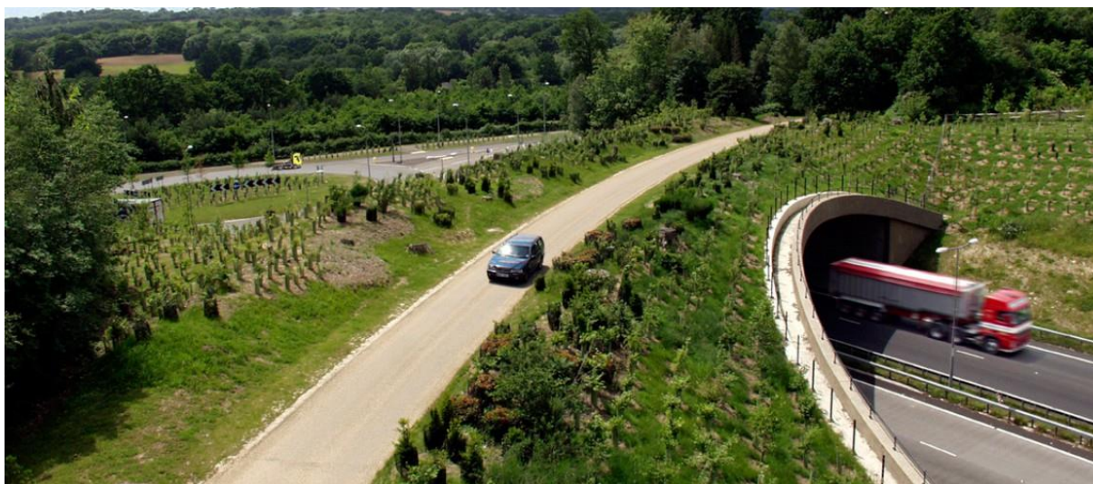
Ryc. 4.25. Zagospodarowanie powierzchni przejścia i zastosowany system odwodnienia przy krawędzi obiektu Źródło: Fira Landscape Limited [1].
