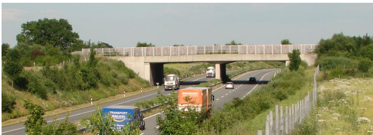
Ryc. 4.9. Przykład przejścia z bardzo gęsto nasadzonymi krzewami na przyczółkach i skarpach wykopu
