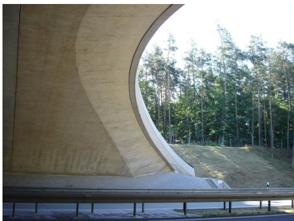
Ryc. 4.97. Łukowa konstrukcja obiektu kierująca wodę opadającą z obiektu, wzdłuż jego krawędzi
