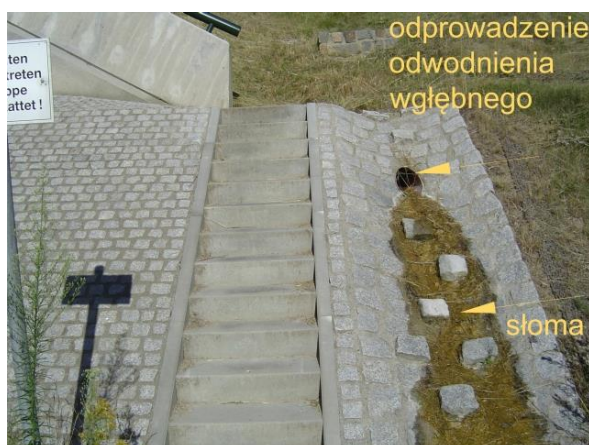
Ryc. 4.102. Wystające pojedyncze kostki kamienne spowalniające warstki nurt splywu pod odprowadzeniem systemu odwodnienia w głębokiej muldzie
