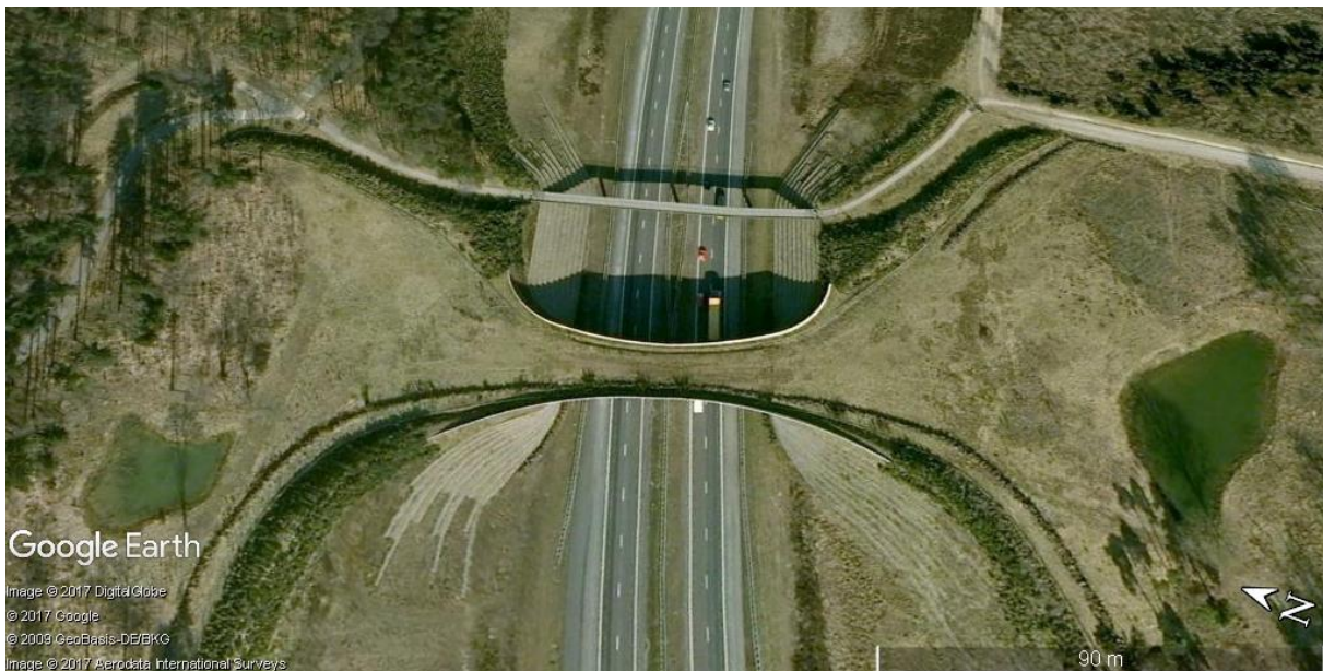
Ryc. 3.40. Detale zagospodarowania i uformowania wałów ziemnych, zastosowane na przejściu górnym Borkeld; wymiary mostu zielonego: szerokość najścia – 126 m, szerokość w linii przyczółków – 3 m, faktyczna szerokość przejścia – 5 m Źródło: zdjęcie satelitarne z Google Earth [163].
