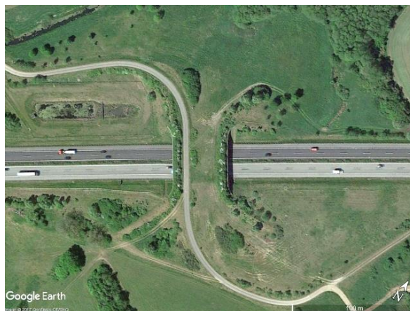
Ryc. 3.83. Roślinność po kilku latach eksploatacji obiektu, osłaniająca ekran betonowy i porastająca wały ziemne (stan z 2018 r. – 14 lat po budowie) Źródło: zdjęcie satelitarne z Google Earth [163].
