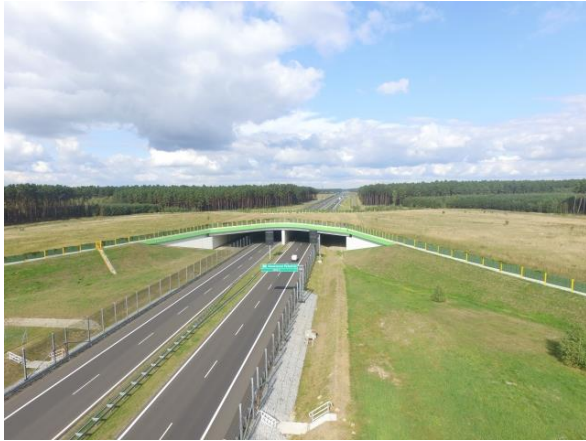
Ryc. 3.38. Paraboliczny kształt przejścia i strefy naprowadzenia Źródło: fot. Piotr Pacelik [156].
