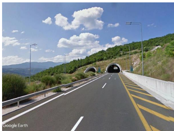
Ryc. 3.58. Stromość wzgórze nad tunelem, wykonanym z blach falistych, z ukośnym zakończeniem Źródło: fot. Street View [164].
