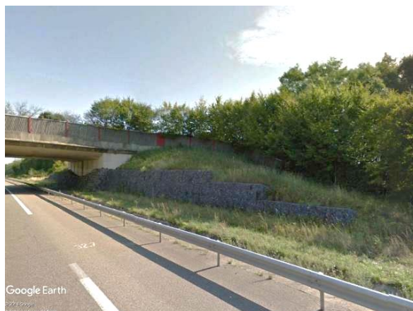
Ryc. 3.48b. Zagospodarowanie skarp wykopu i strefy najścia na moście zielonym we Francji, wybudowanym nad autostradą A35 Źródło: fot. Street View [164].
