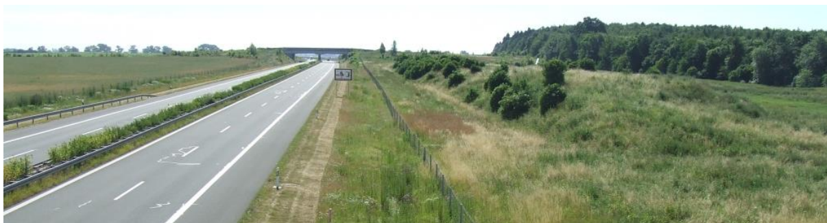
Ryc. 6.6. Wał ziemny uformowany na dojściu do przejścia Starkshof Źródło: fot. Radosław Madej [129].
