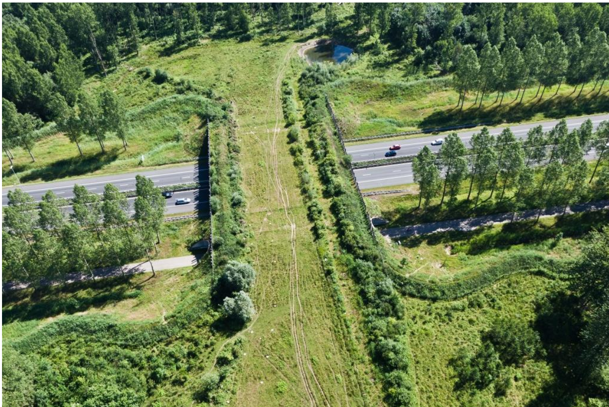
Ryc. 4.7. Widok zagospodarowanego przejścia górnego, ocenianego jako jedno z najlepszych rozwiązań ekologicznych Źródło: fot. Joop van Houdt, State of The Netherlands, Ministry of Infrastructure and Environment, Directorate-General Rijkswaterstaat [93].
