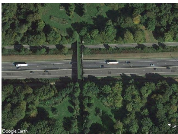
Ryc. 2.13. Przykład wąskiego przejścia, o szerokości 8 m, wybudowanego nad autostradą A4 Źródło: zdjęcie satelitarne z Google Earth [163].
