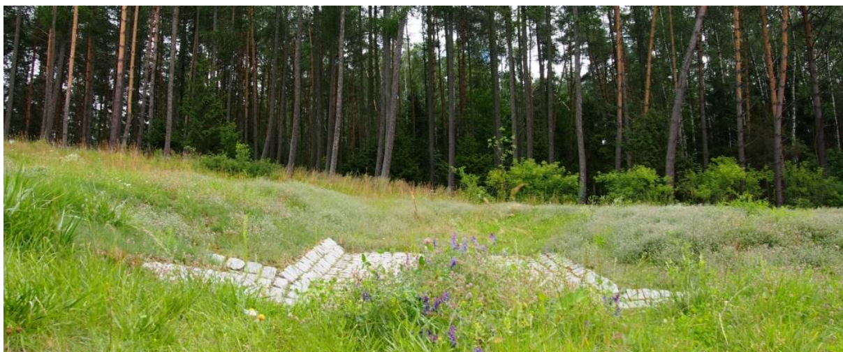
Ryc. 4.122. Niedopuszczalne na terenie przejścia miejsca wybrukowane, generujące istotne oddziaływanie barierowe Źródło: fot. Radosław Maron [134].
