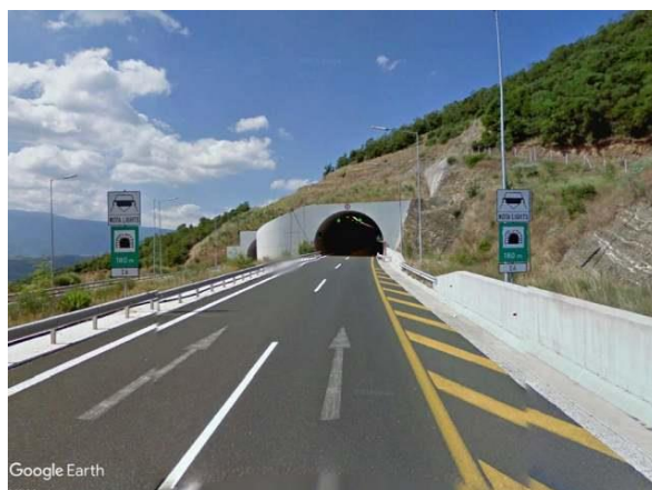
Ryc. 3.60. Stromość wzgórze nad tunelem, wykonanym z blach falistych, z prostokątną ścianą czołową Źródło: fot. Street View [164].
