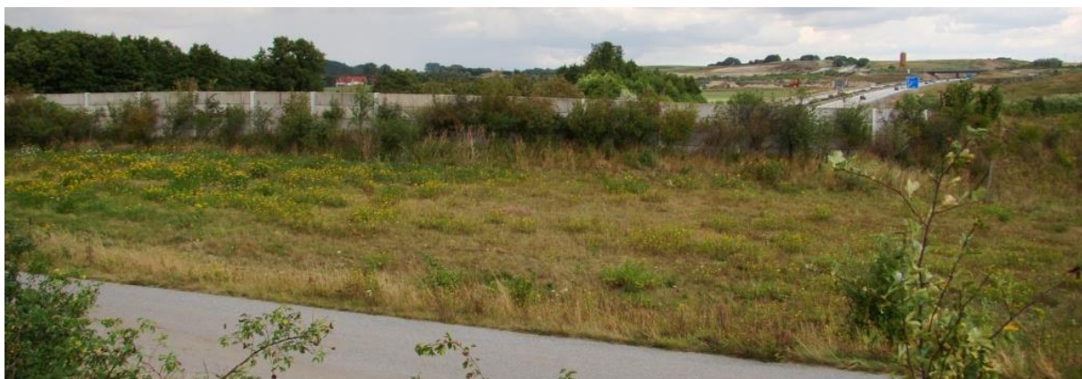
Ryc. 6.15. Ekran betonowy i wał ziemny (o wysokości 0,5 m) obsadzony rzadko krzewami (o wysokości do 1,5 m)
