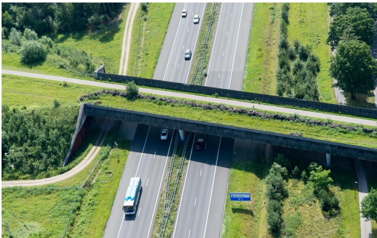
Ryc. 4.82. Początek zachodniego najścia na strefę migracji i jej wygrodenie po kilku latach użytkowania karpinami Źródło: fot. State of The Netherlands, Ministry of Infrastructure and Environment, Directorate-General Rijkswaterstaat [63].
