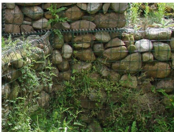
Ryc. 4.68. Przykład wału ułożonego z gabionów, wolno porastającego trawą i mchem
