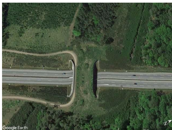
Ryc. 4.73. Stan zagospodarowania w 2017 r. strefy migracji i najść na przejście zespolone (widoczna jest duża ekspansja roślinności) Źródło: zdjęcie satelitarne z Google Earth [163].
