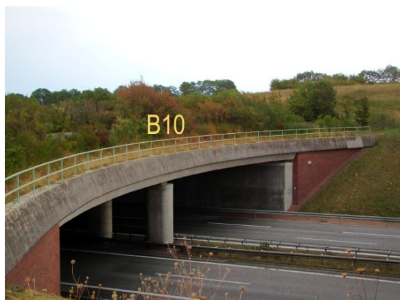
Ryc. 6.46. Widok zachodniej strony obiektu i stan zieleni w trakcie pomiarów (lokalizacja punktu B10 nad pasem dzielącym, na środku półki za ekranem od strony jezdni)
