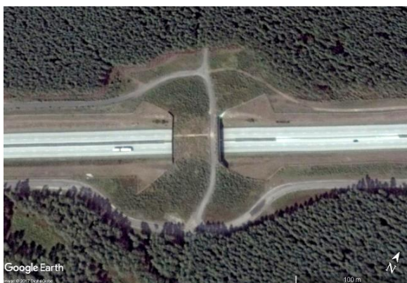
Ryc. 3.69. Stan zagospodarowania mostu zielonego po sześciu latach od oddania go do użytku Źródło: zdjęcie satelitarne z Google Earth [163].
