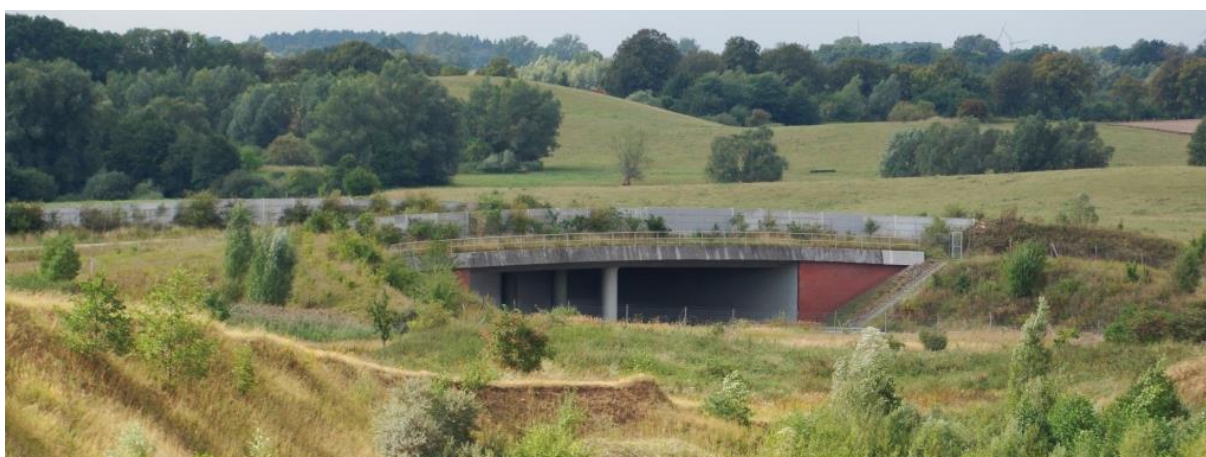
Ryc. 3.79. Ekran betonowy z płyt prefabrykowanych na przejściu górnym w Niemczech (o wysokości 3 m)
