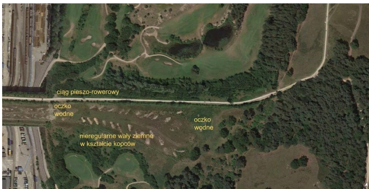
Ryc. 2.68. Najdłuższe przejście – część wschodnia i najście na obiekt z terenu starych nieczynnych kamieniołomów (stan roślinności osiem lat po wybudowaniu)
