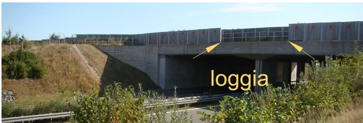
Ryc. 3.63. Ekran drewniany z loggią nad pasem dzielącym (autostrada A20 w Niemczech)
