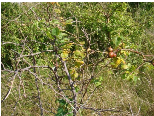
Ryc. 6.10. Uschnięte krzewy dzikiej róży rosnące na skarpach przyczółków
