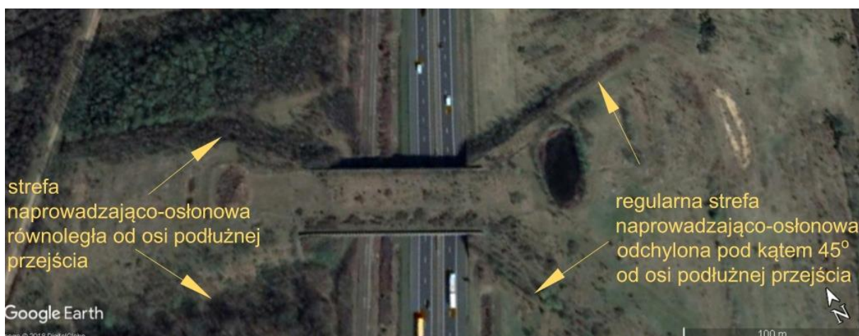
Ryc. 5.20. Przykład przejścia górnego z bogatym zagospodarowaniem w strefie migracji (zagajniki i oczka wodne) oraz z różnie ukształtowaną i zagospodarowaną strefą naprowadzająco-osłonową po obu stronach przejścia Źródło: zdjęcia satelitarne z Google Earth [163].
