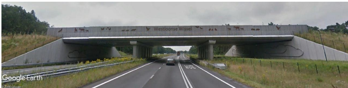
Ryc. 4.91. Przykład oznakowania przejścia Westloonse Wissel podobiznami zwierząt wyciętymi ze sklejki i umocowanymi na całej długości drewnianego ekranu Źródło: fot. Street View [164].
