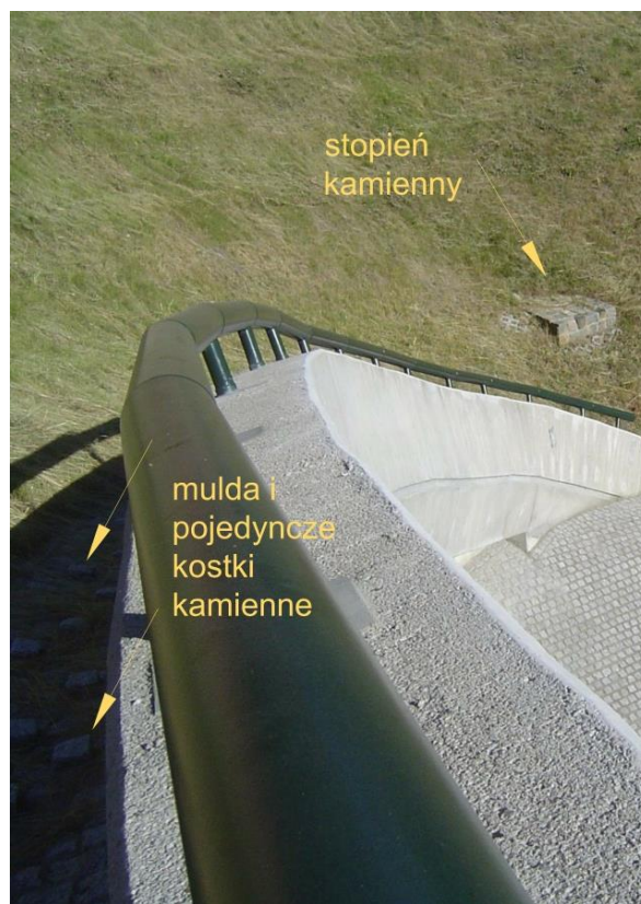
Ryc. 4.103. Detale muldy, z wystającymi pojedynczymi kostkami kamiennymi (patrz ryc. 4.98), i stopień kamienny
