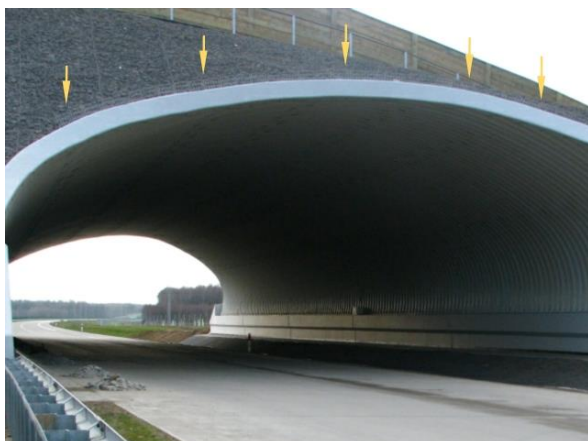
Ryc. 4.123. Miejsce lokalizacji płotków zabezpieczających krawędź obiektu przed tworzeniem się sopli
