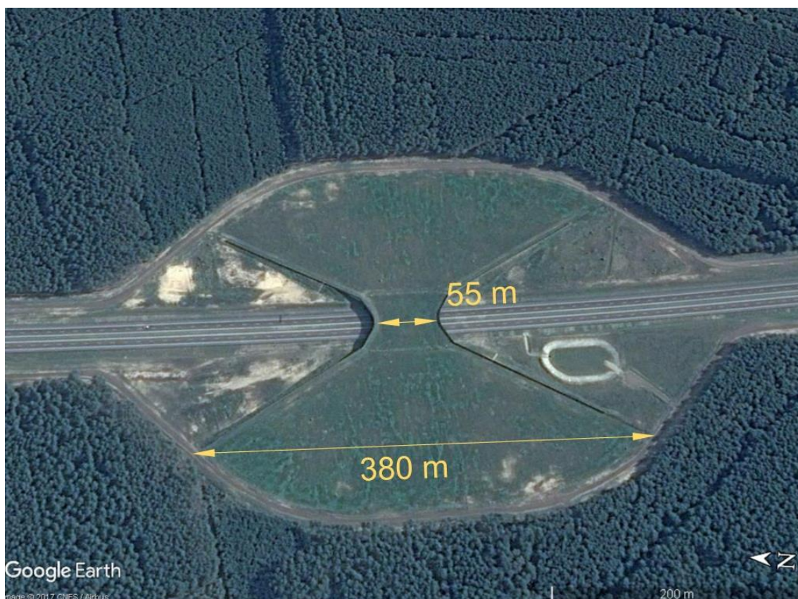
Ryc. 3.35. Największe pod względem obszaru w Polsce przejście górne PZD-25 nad drogą ekspresową S3 (o powierzchni ok. 8 ha, szerokości najścia ok. 380 m, faktycznej szerokości przejścia 55 m) Źródło: zdjęcie satelitarne z Google Earth [163].
