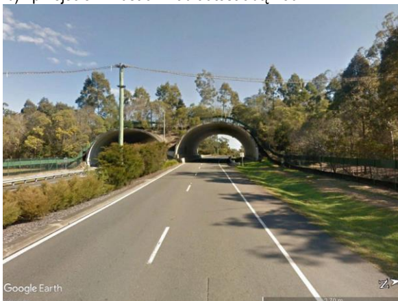
Ryc. 3.12. Porównanie widoku krawędzi obiektu i uformowanego naziemu wybudowanych wąskich przejść we Francji i w Australii
