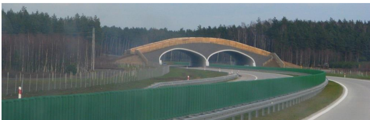
Ryc. 3.20. Przejście górne nad autostradą A4 w Polsce
