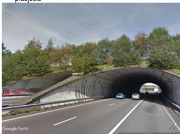
Ryc. 3.6. Proporcjonalne wykorzystanie długości konstrukcji i uzyskanie faktycznej szerokości przejścia równej 50 m (przykład przejścia w Holandii nad autostradą A50) Źródło: a) zdjęcie satelitarne z Google Earth [163], b) fot. Street View [164].
