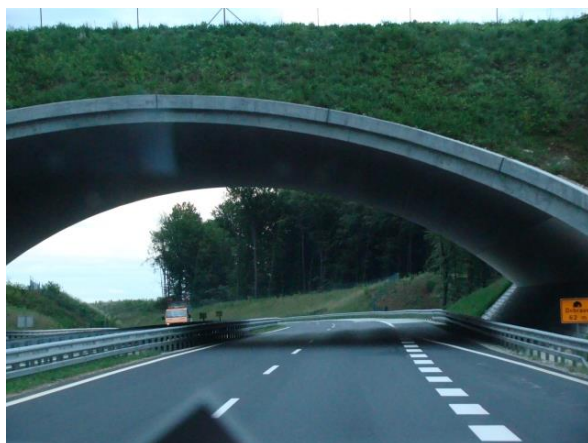
Ryc. 2.48. Przykłady dwóch wąskich mostów zielonych niedoświetlanych od spodu konstrukcji i bardzo słabo zagospodarowanych w strefie najścia i migracji
