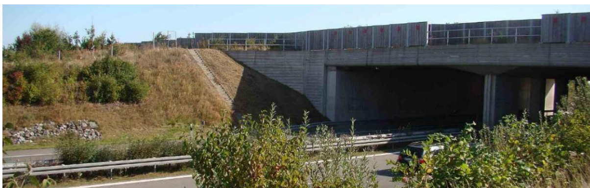
Ryc. 6.22. Widok przejścia górnego z ekranem drewnianym, z loggią nad pasem dzielącym
