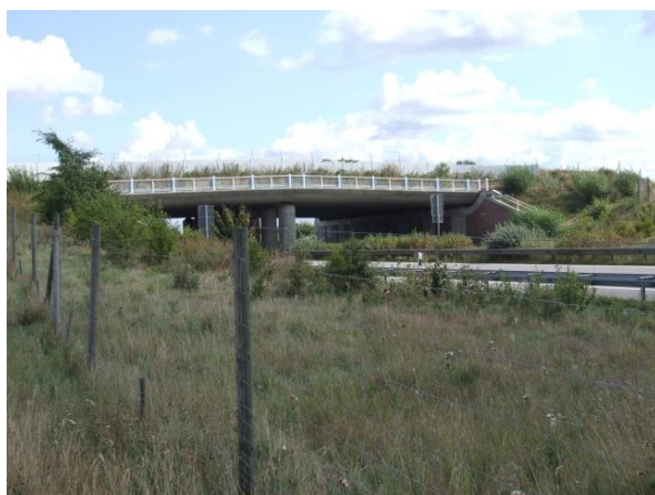
Ryc. 3.80. Niewysokie wały ziemne, porośnięte niewymagającą roślinnością, uformowane przed ekranem Źródło: fot. Mariusz Schab [184].
