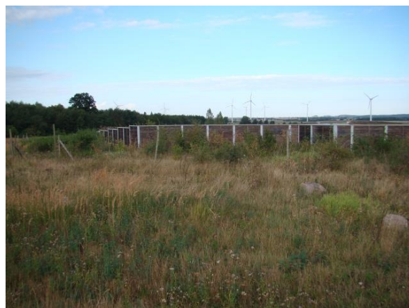
Ryc. 4.14. Ekrany przy najściu odgięte pod kątem 45° od osi podłużnej obiektu
