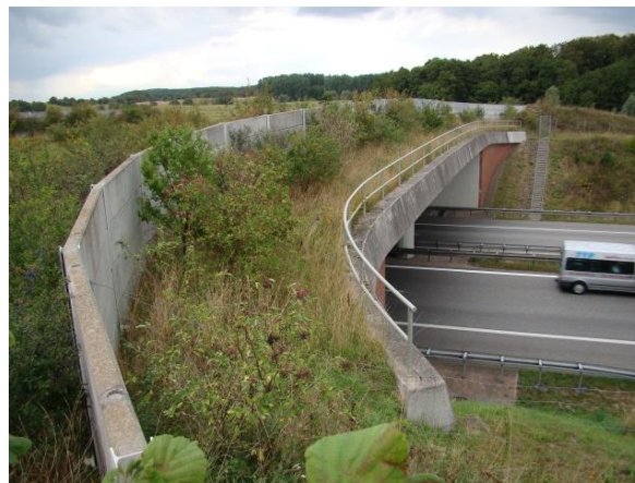
Ryc. 6.56. Zagospodarowanie wałów ziemnych na półce za ekranem betonowym (strona wschodnia)
