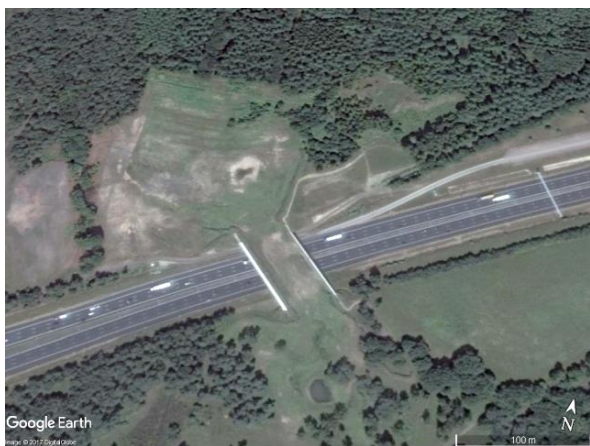
Ryc. 3.85a. Stan przejścia Wolfheze zaraz po zakończeniu budowy Źródło: zdjęcie satelitarne z Google Earth [163].
