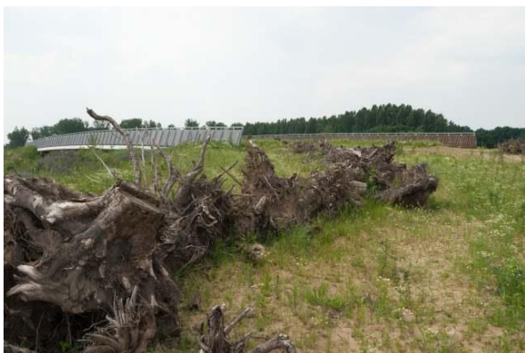
Ryc. 4.78. Nieregularnie ułożone karpiny w strefie najścia na przejściu Waterloo w Holandii, nad autostradą A73 Źródło: fot. Marcel Huijser [94].
