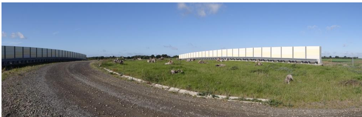
Ryc. 3.86. Przykład przejścia zespolonego z ekranami kasetowymi z PCV kończącymi się w linii przyczółku
