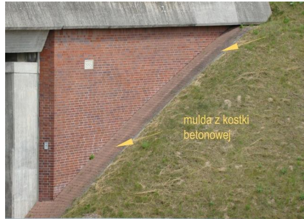
Ryc. 4.104. System odwodnienia odprowadzający wodę z powierzchni konstrukcji do ścieku stycznego do ścian przyczółku (ściek typu mulda wykonany z kostki betonowej)
