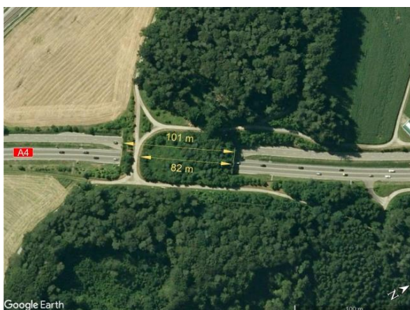
Ryc. 4.30. Przejście górne nad autostradą A4 w Szwajcarii, koło Henggart, z nieprawidłowo wyprofilowaną drogą lokalną i dwoma skrzyżowaniami na powierzchni obiektu Źródło: zdjęcie satelitarne z Google Earth [163].
