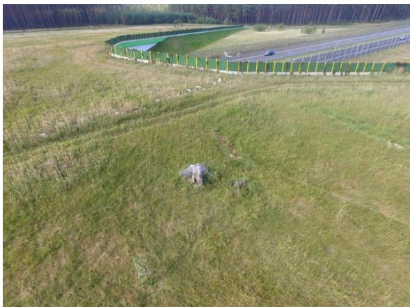
Ryc. 4.76. Pojedyncze karpiny i głązy ułożone na powierzchni mostu zielonego Źródło: fot. Piotr Pacelik [156].
