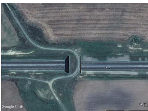
Ryc. 3.87. Przejście zespolone i nieprawidłowo wytrasowana drogi żwirowa na terenie obiektu [163]
