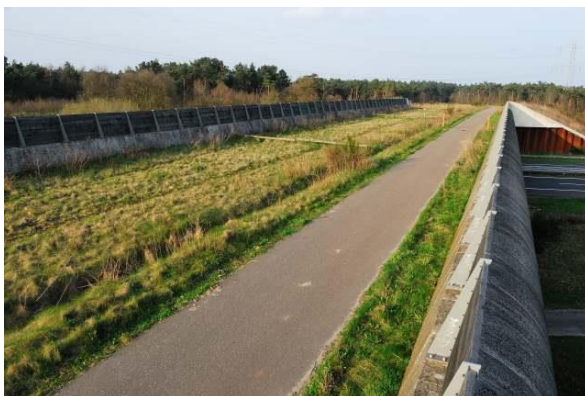
Ryc. 4.79. Pnie ściętych drzew ułożone w strefie migracji na przejściu Slabroek; stan zaraz po oddaniu do użytku (2005–2007) Źródło: fot. Marcel Huijser [94].
